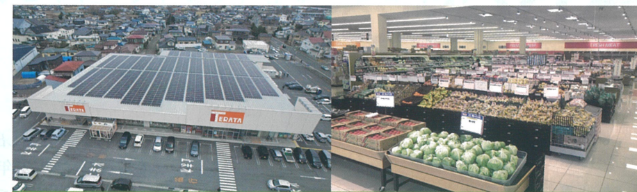
(左) テラタバイパス店の屋根2100平方メートルに812枚の太陽光パネルを設置している (右) 生鮮品の品揃えに力を入れるテラタの店内には多くの冷蔵ケースが並ぶ
